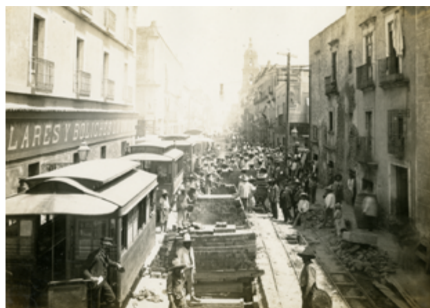
Figura 3. Obras de saneamiento
